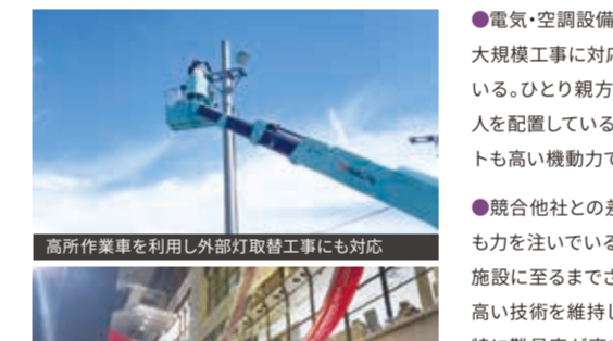
高所作業車を利用し外付け取付工事にも対応
