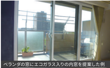
ベランダの窓にエコガラス入りの内窓を提案した例
